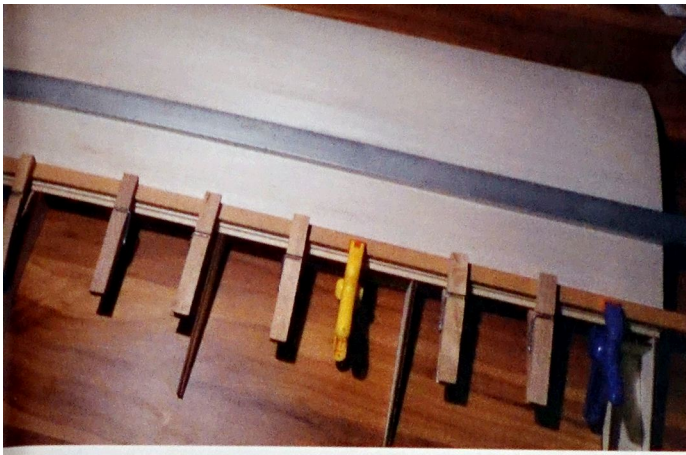
Hält man sich genau an die Anleitung, geht auch die Beplankung der Tragflächen leicht von der Hand...
